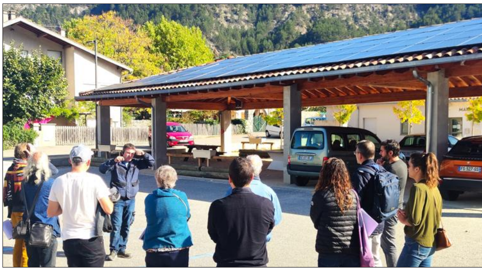
La toiture de la halle couverte de la Marpa est la plus grande surface couverte de panneaux photovoltaïques sur une structure communale.
