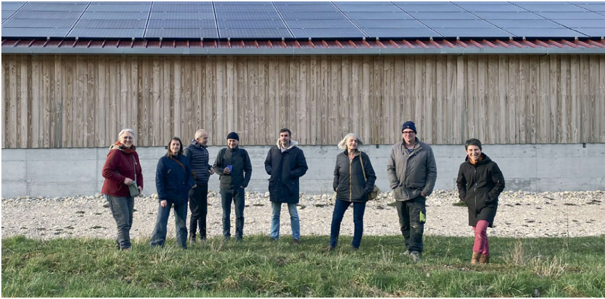
Le projet photovoltaïque de Dwatts, installé sur la toiture du bâtiment agricole de la ferme des Fourniers, a permis à Sébastien Michel d'investir pour développer la vente directe de noix
