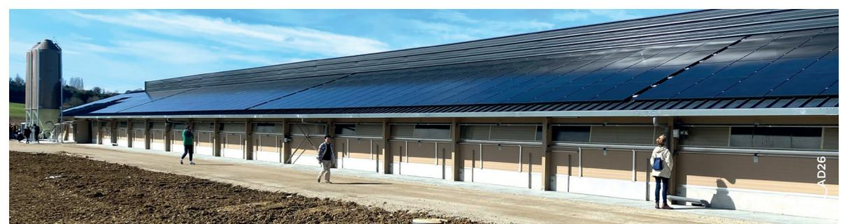
▲ Sur la toiture du bâtiment, sont installés 1 300 m<sup>2</sup> de panneaux photovoltaïques (285 kWc de puissance).
